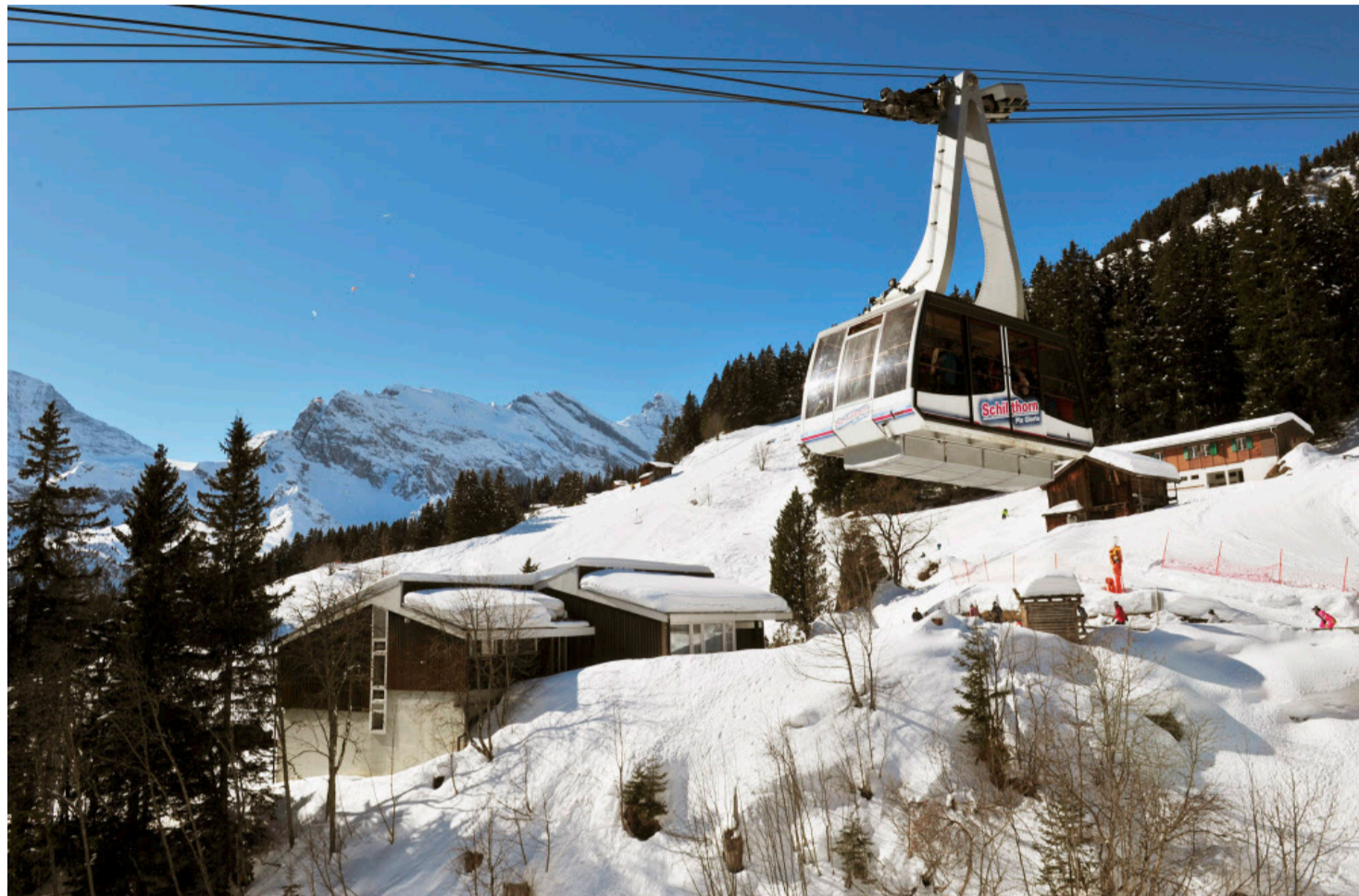
Das Schulhaus (links) oberhalb der Schilthornbahnstation in Mürren.
